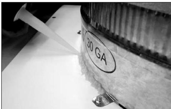
9. Etanchez l'espace entre le collier et l'avant du panneau en utilisant un produit d'étanchéité pour conduits. Attendez jusqu'au séchage. Un produit aqueux à faible teneur en COV est recommandé, comme le DP 1010.
