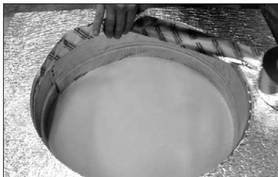
10. Mettez l'isolation sur la face intérieure du panneau et fixez l'isolation au collier avec un ruban adhésif pour conduits.
