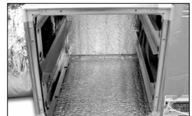
7. Retirez les filtres et fixez par le panneau depuis l'intérieur au système de traitement d'air
