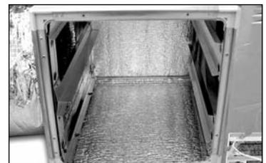
6. Retirez les filtres et fixez par le panneau depuis l'intérieur au système de traitement d'air.
