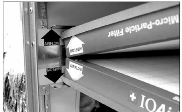
6. Assurez-vous d'aligner les filtres avec les flèches du débit d'air qui doivent correspondre aux flèche du débit d'air sur l'armoire.
